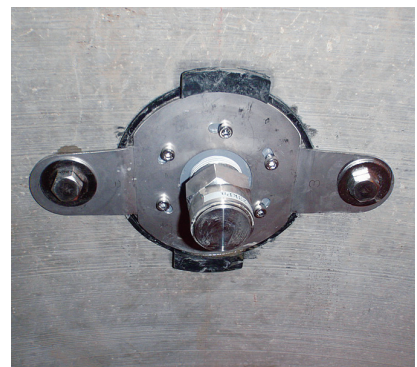
集水管取付状況 (マンホール内)
