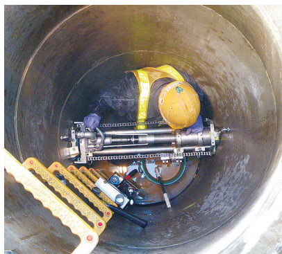
専用機械による施工状況
